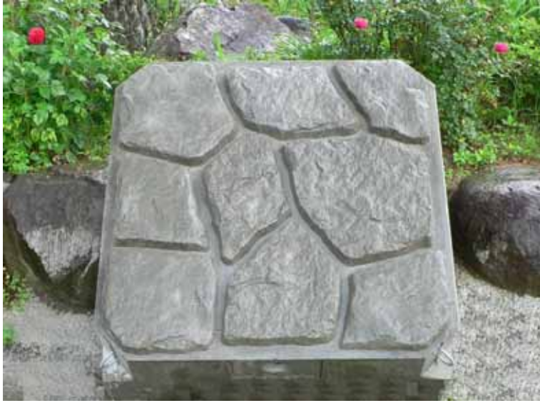
擬岩面の砕砂仕上げ
