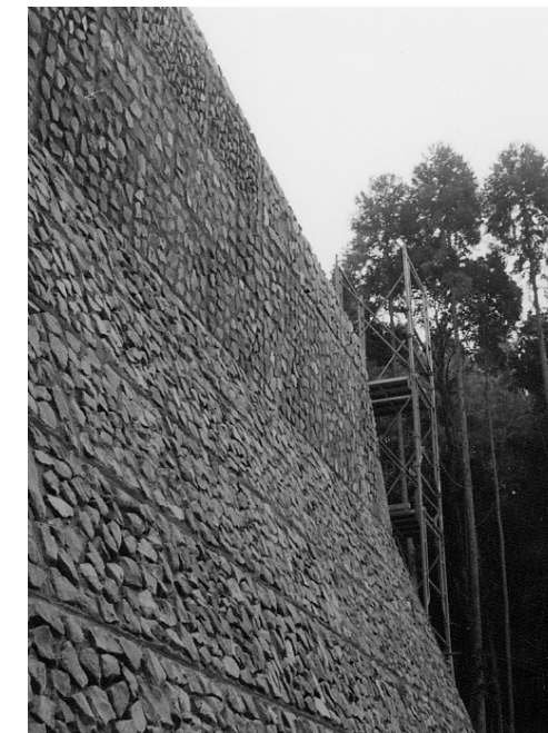
完成下流側（Jフォーム：柱）
