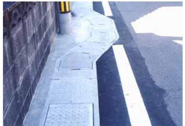
V S電柱巻き込み：設置状況
