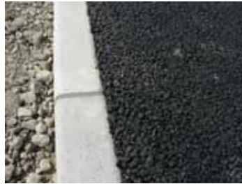
舗装止め：継ぎ手拡大
