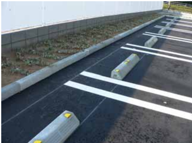
舗装止めブロック工：車止め・設置完了
