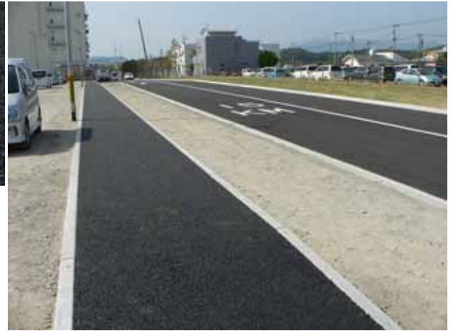
透水性舗装・施工完了
