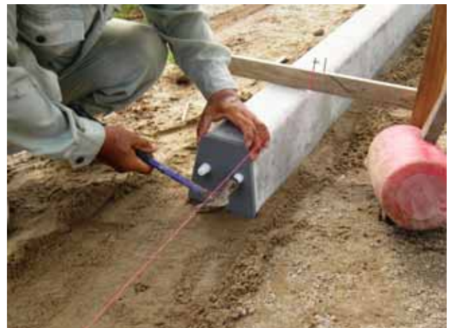
ブロックの目地処理状況
