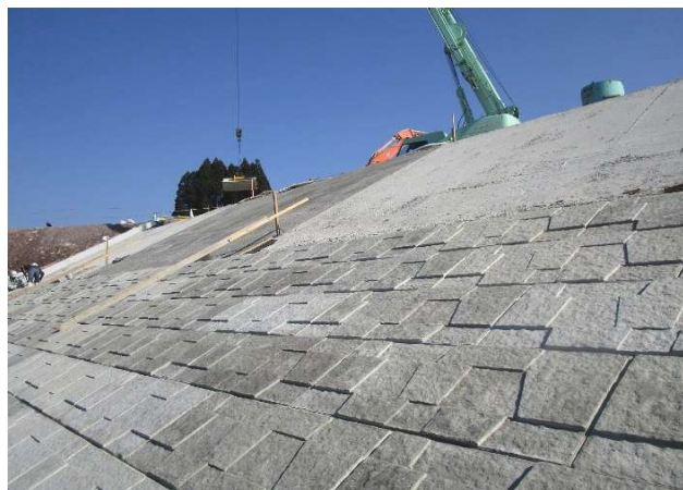
川内川河川事務所 1:2.0 曾木地区
